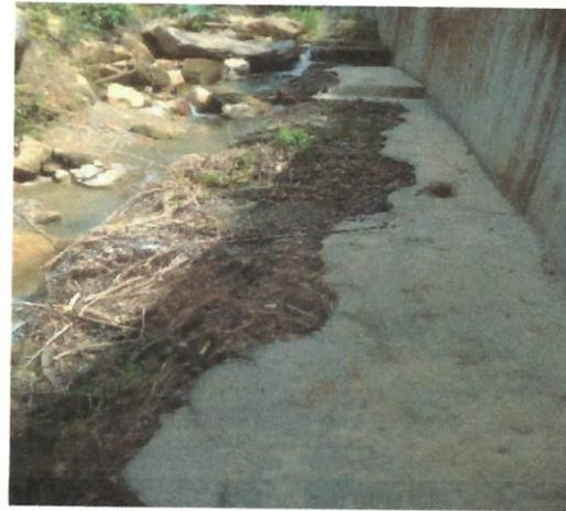
**Imagenes N° 007 y 008:** Erosión en las estructuras de la captación de Ahuashiyacu ocasionado por la crecida de la quebrada Ahuashiyacu
