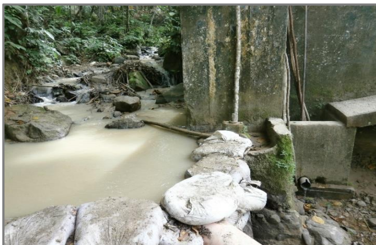
Imagen N° 5: Vista del riesgo de contaminación de la captación Ahuashiyacu
