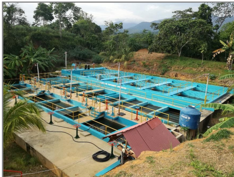
Imagen N° 13: Vista de la PTAP Ahuashiyacu
