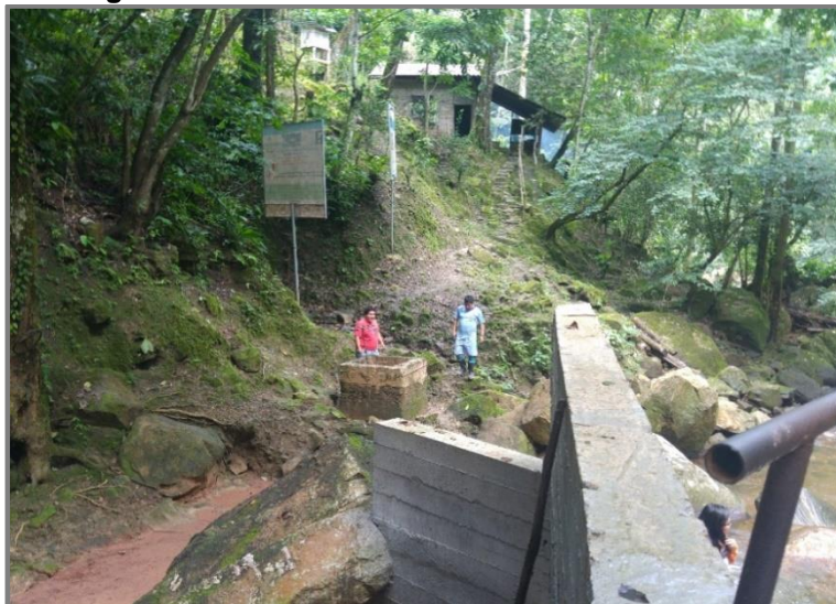
Imagen N° 3: Vista de la cámara de válvula de control
