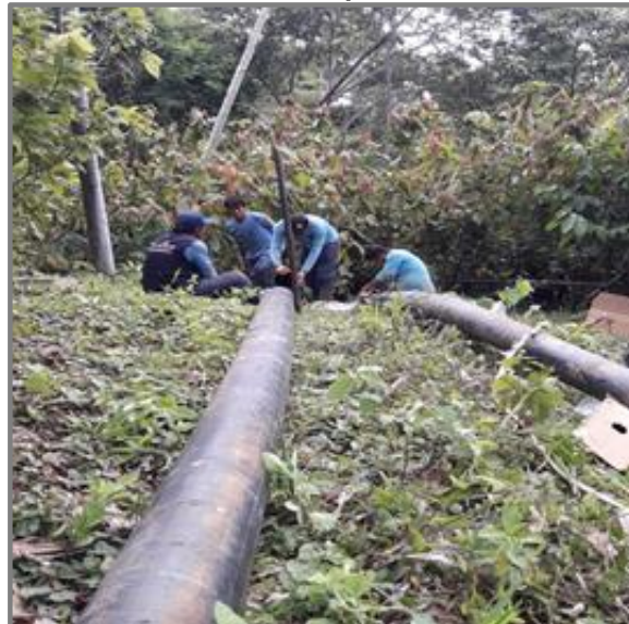
Fuente: Cambio de unión Dresser por acoples con Electrofusión PMO (31.01.19)
