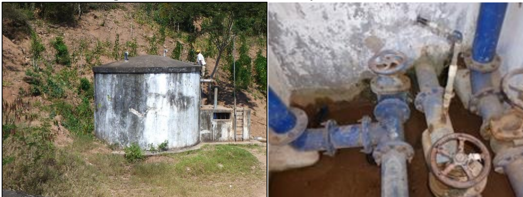
Imagen N° 42: Reservorio de 90 m 3 y caseta de válvulas.
