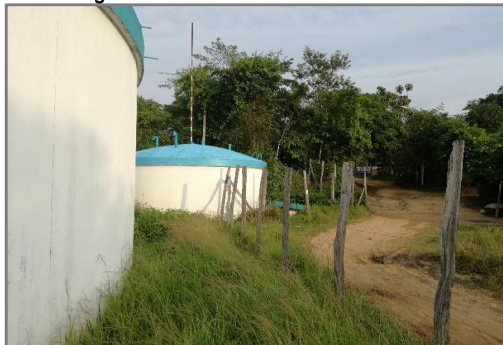
Imagen N° 16: Vista del reservorio R-120
