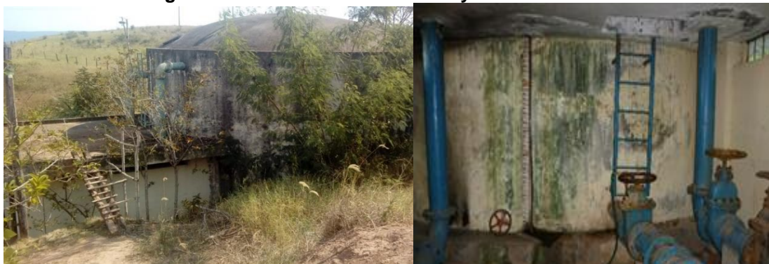
Imagen N° 43: Reservorio de 250 m 3 y caseta de válvulas.
