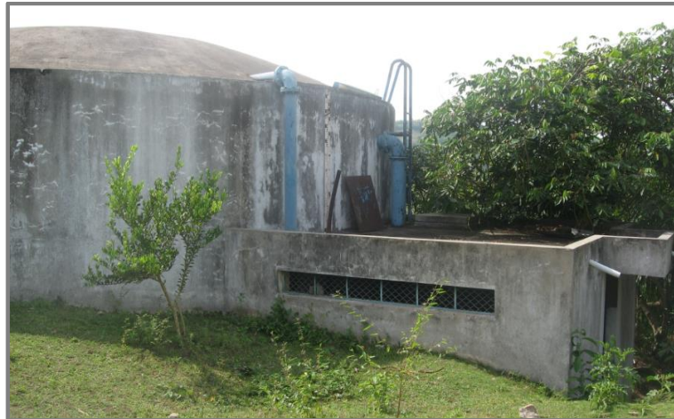
Imagen N° 29: Vista del reservorio de 500 m3
