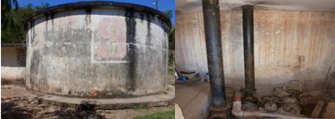
Imagen N° 41: Reservorio de 350 m 3 y caseta de válvulas
