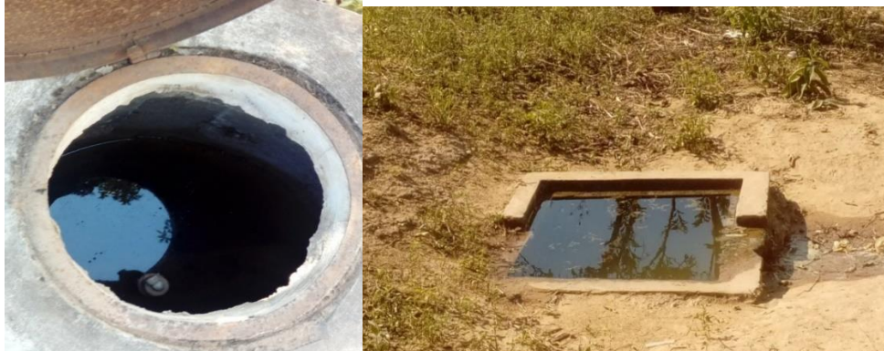
Imagen N° 40: Válvulas de purga de aire y sedimentos expuestas e inundadas.
