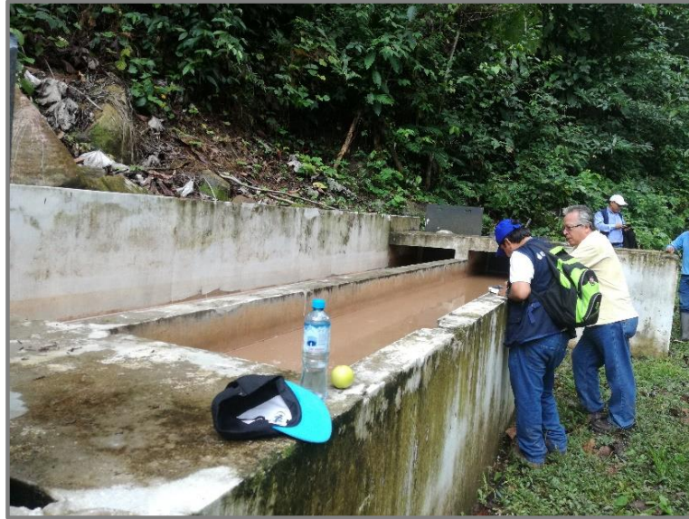
Imagen N° 19: Vista del pretratamiento
