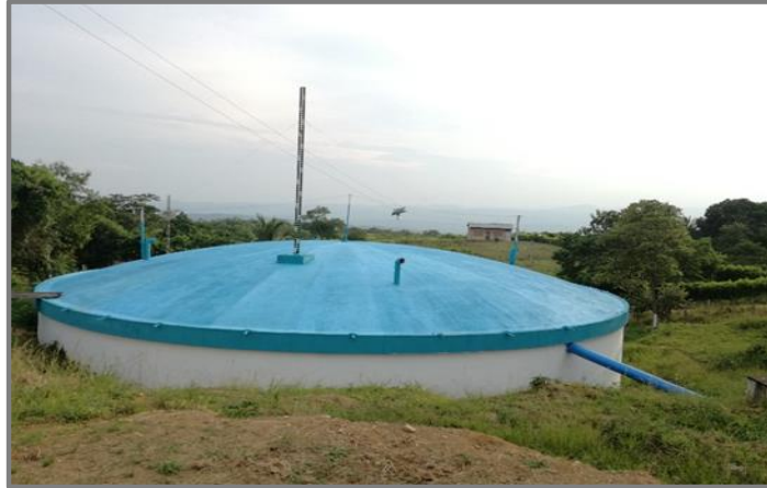
Imagen N° 15: Vista del reservorio R-2800
