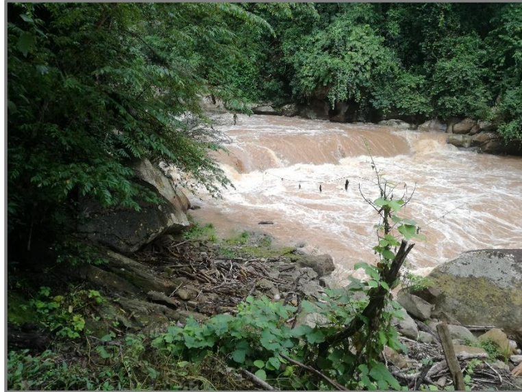
Imagen N° 18: Vista de la captación Shima
