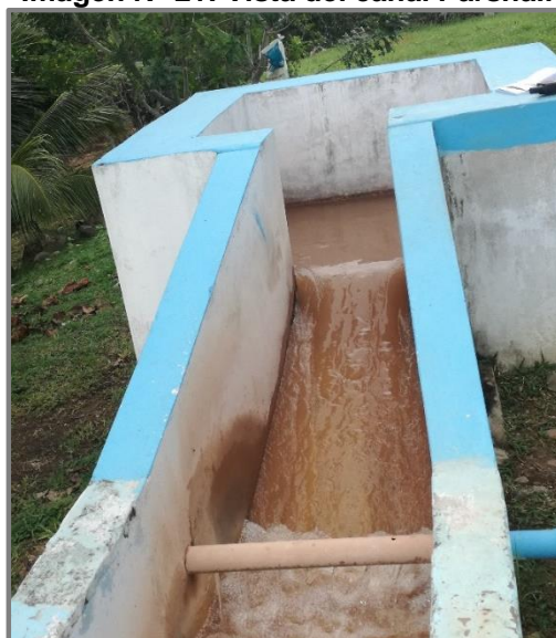
Imagen N° 21: Vista del canal Parshall
