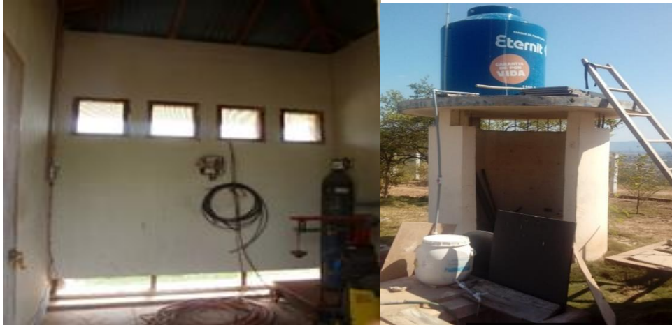
Imagen N° 39: Sistema de dosificación inoperativo y dosificación artesanal.
