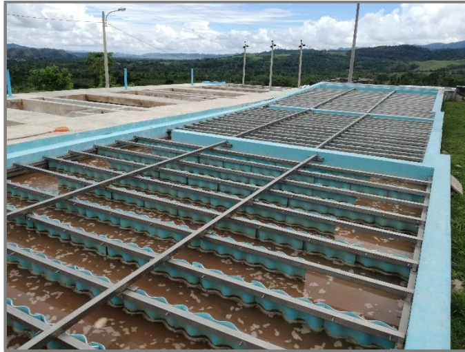
Imagen N° 22: Vista del canal Parshall
