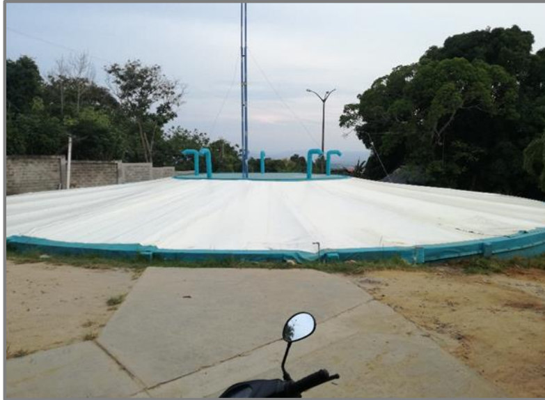
Imagen N° 14: Vista del reservorio R-1256
