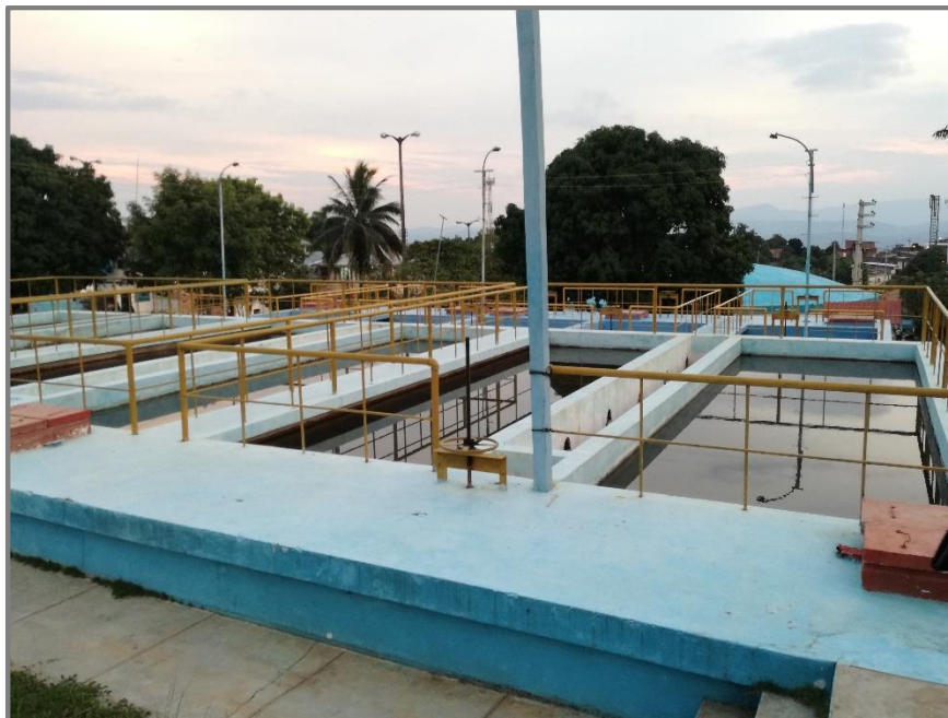
Imagen N° 12: Vista de la PTAP Cachiyacu
