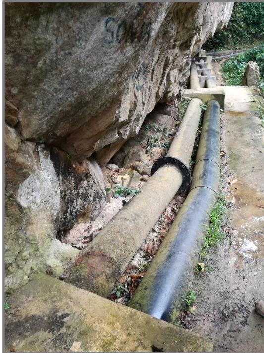
Imagen N° 10: Vista de la línea de conducción de Ahuashiyacu
