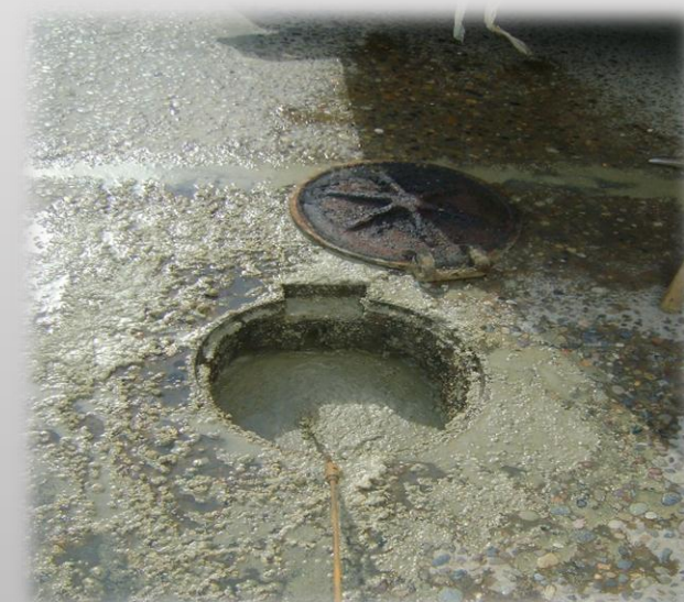
JR. TARAPOTO CON JR. CUMBAZA: Inicialmente el buzón se encontraba rellenos con material de afirmado y cubierta con hojas.
