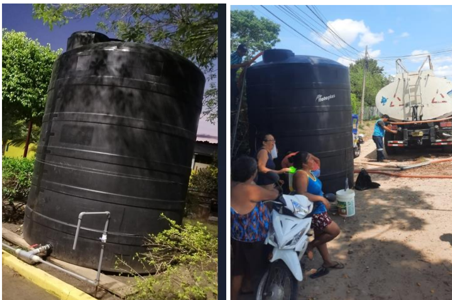
Instalación de tanques de 10,000m 3 en zonas críticas de la Sede Central durante el periodo de sequía
